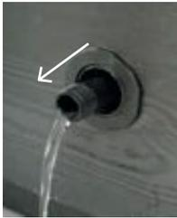
5. Während des Herausziehens wird der Wasserdurchfluss reduziert
