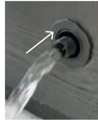
4. Durch Drücken des Ventils nach innen wird der Wasserdurchfluss erhöht
